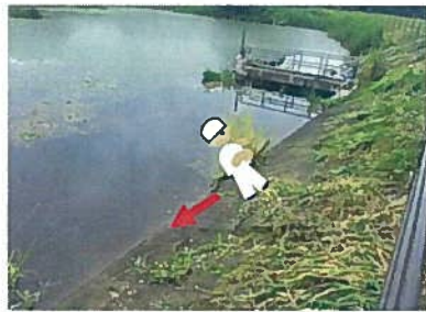
(ため池堤体の急傾斜)
