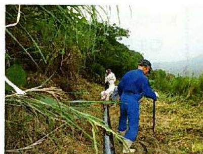
水路の泥上げ
